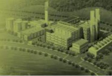
열병합발전은 전기와 열을 동시에 생산하는 종합에너지시스템(Total Energy System)으로서 일반적으로 고온부는 전기, 저온부는 공장의 공정(Process)용 증기 또는 온수로 만들어 주거 및 사무용시설에 난방용으로 공급하는 에너지 시스템입니다.
